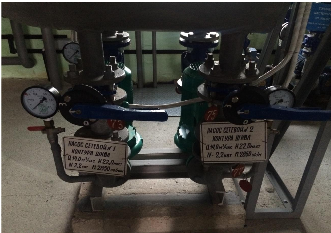
Рисунок 18. Вспомогательное оборудование, установленное в котельной ГУП РК «Крымтеплокоммунэнерго» по пер. Больничный 3.
