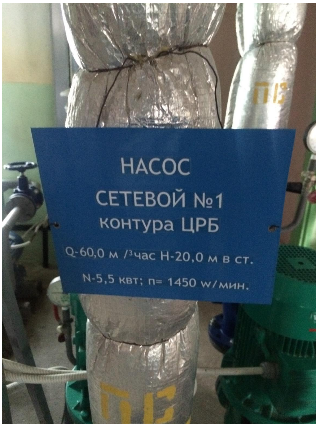
Рисунок 16. Вспомогательное оборудование, установленное в котельной ГУП РК «Крымтеплокоммунэнерго» по пер. Больничный 3.
