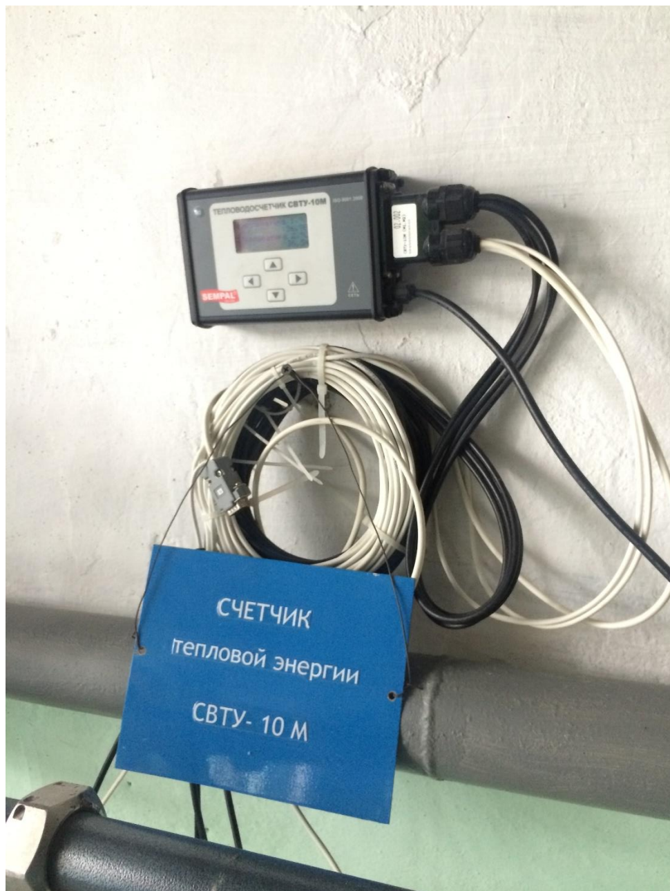
Рисунок 26. Прибор учета тепловой энергии котельной ГУП РК «Крымтеплокоммунэнерго» по пер. Больничный 3.
