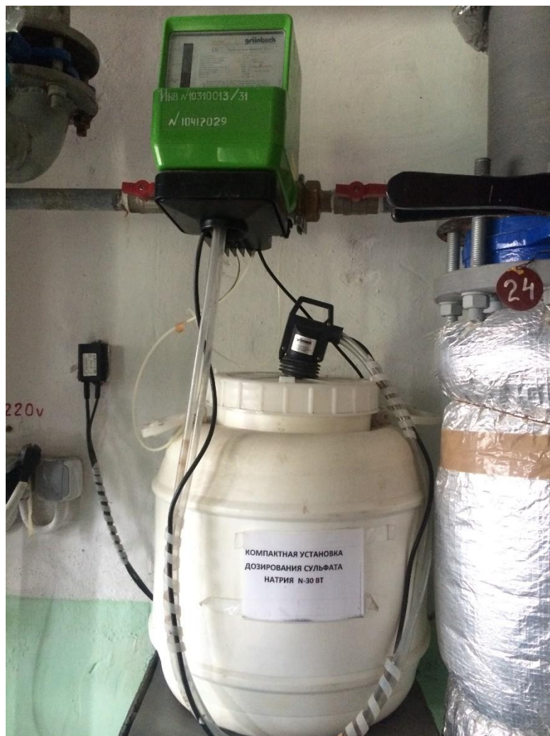
Рисунок 27. Установка дозирования сульфата натрия котельной ГУП РК «Крымтеплокоммунэнерго» по пер.Больничный 3.
